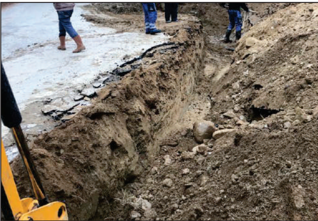
MUTAFLAR MAHALLESİ YÖRÜKLER KÜME EVLERİ SOKAK KORGE BORU DÖŞEME ÇALIŞMASI ESKİ VE YENİ HALİ
