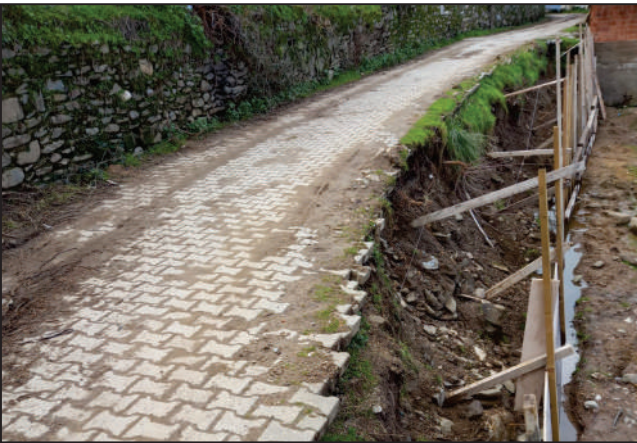
HALIKÖY NAHALLESİ NEHİR KÜME EVLERİ SOKAK YOL PERDE BETON ÇALIŞMASI ESKİ VE YENİ HALİ
